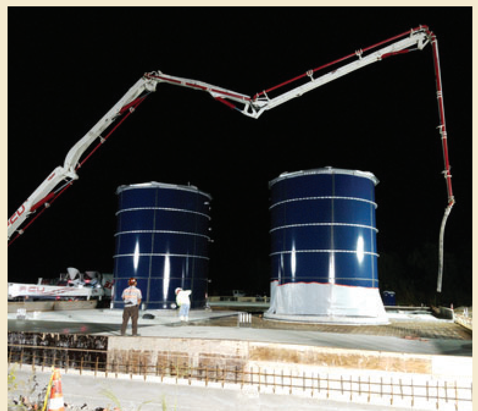
Aboveground Storage Tank Foundation Pour
